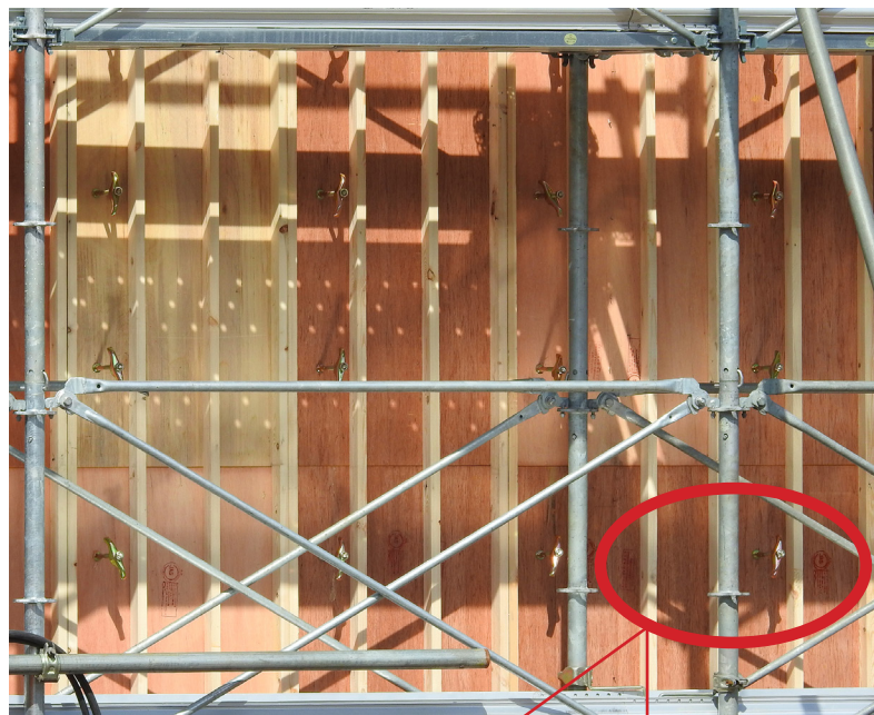
写真：有明アリーナの建設現場で2018年5月11日に撮影 写真1&2：コンクリート型枠合板として使われているコリンド社木材、 写真3：コリンド・グループのバリクパパン・フォレスト・インダストリーズ社の 木材であることを示している、 写真4：住友林業（008）による輸入を示している
