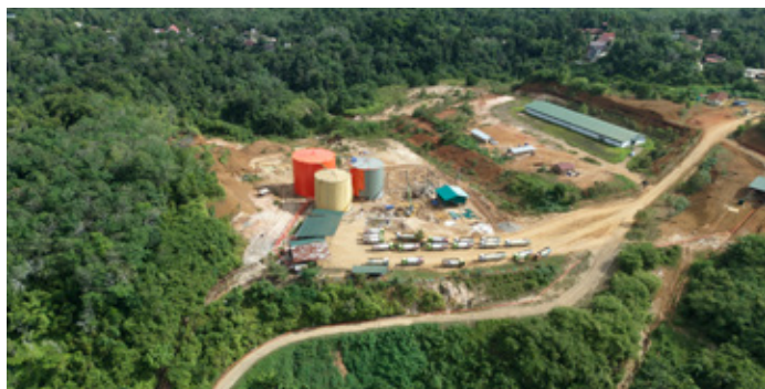
ファースト・リソーシズは新たに2基の貯蔵タンクを建設し、貯蔵能力を拡大した、2026年第2四半期
