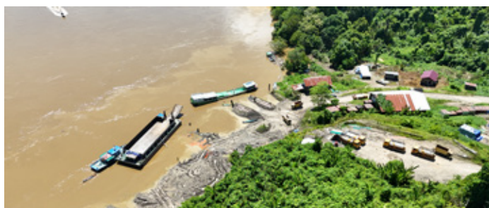
「FPS16A」バージ船にへパーム原油をポンプ移送するPT SAA搾油工場のトラック
