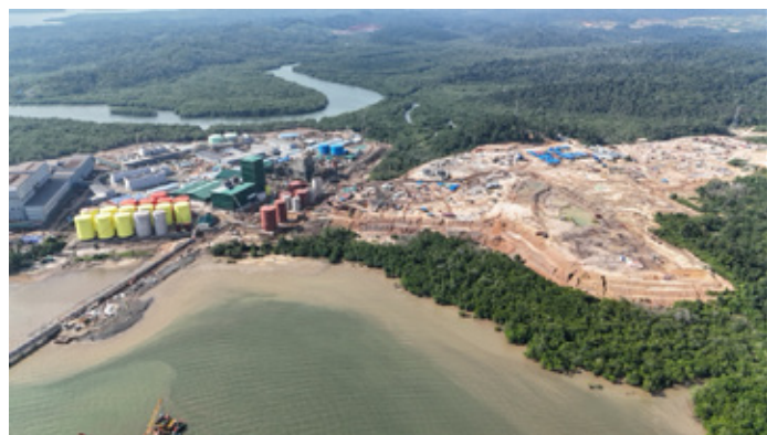
バリクパパン湾で建設中のPT WPS製油所、2025年第3四半期
